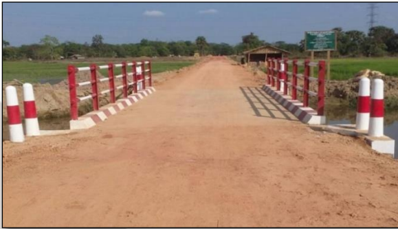
တိုက်ကြီးမြို့နယ်၊ သာယာကုန်းကျေးရွာ ကွန်ကရစ်တံတား ဆောင်ရွက်ပြီးစီးမှု
