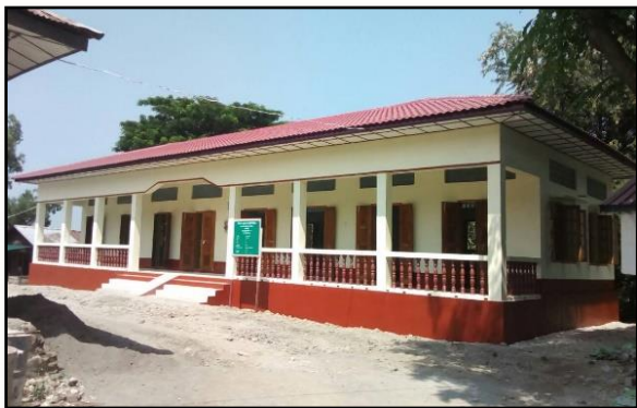
ကျေးလက်ဆေးပေးခန်းဆောက်လုပ်ခြင်း၊ နတ်ချောင်း ကျေးရွာ၊ ကလေးမြို့၊ စစ်ကိုင်းတိုင်းဒေသကြီး
