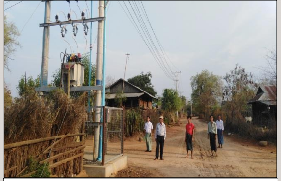
မလှိုင်မြို့နယ်၊ ဆည်ကျေးရွာတွင် မီးလင်းရေးလုပ်ငန်း ဆောင်ရွက်ခြင်း
