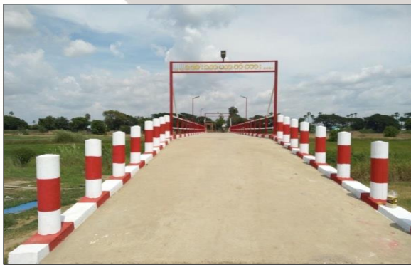
ချောင်းကူးကွန်ကရစ်တံတားတည်ဆောက်လုပ်ခြင်း၊ ကိုးရှင်းကျေးရွာ၊ မုံရွာမြို့နယ်၊ စစ်ကိုင်းတိုင်းဒေသကြီး
