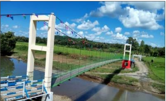
မင်းတုန်းမြို့နယ်၊ ကြက်ဝကျေးရွာ ကြိုးတံတား တည်ဆောက်ခြင်း
