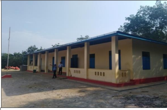
ကွမ်းလုံမြို့နယ်၊ စံပြကျေးရွာတွင် မူလတန်းကျောင်း တည်ဆောက်ခြင်း
