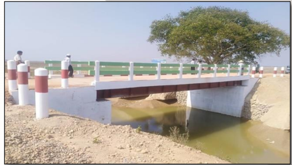
ဘားအံမြို့နယ်၊ ထုံးအိုင်ကျေးရွာ ကွန်ကရစ် တံတားတည်ဆောက်ခြင်းလုပ်ငန်း
