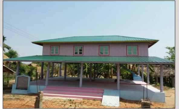
ကော့ကရိတ်မြို့နယ်၊ ကော့ပလံကျေးရွာ ရွာတွင်းကွန်ကရစ်လမ်းဖောက်လုပ်ခြင်း
